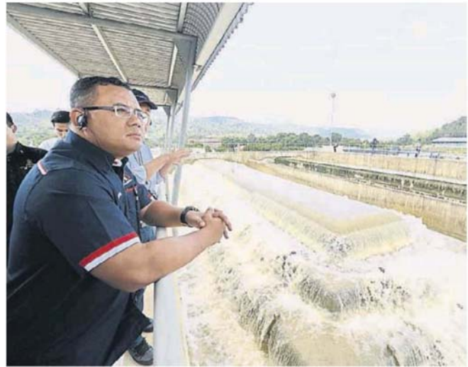
■阿米鲁丁周三到冷岳2滤水站巡视,目前工程进度已达80%。
