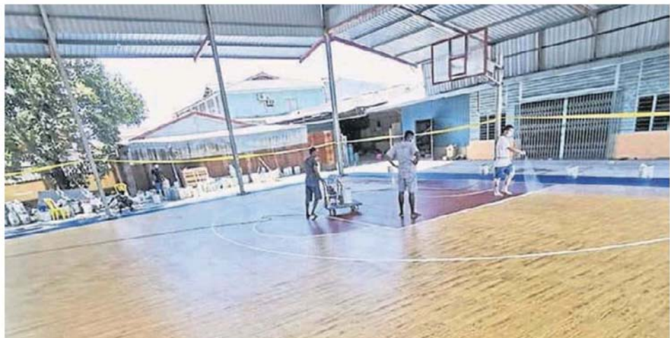
■使用聚氨酯胶粘剂来回涂上8层，最後再压上木纹的地板，让换上新装的海口渔村篮球场变得更吸引人。
