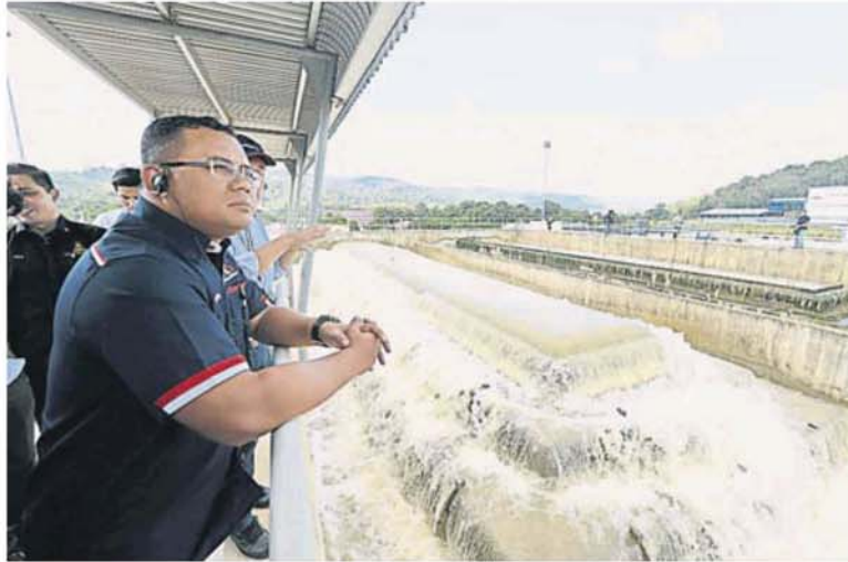
阿米鲁丁周三巡视冷岳 2 滤水站，该滤水站目前工程进度已达 80%。
